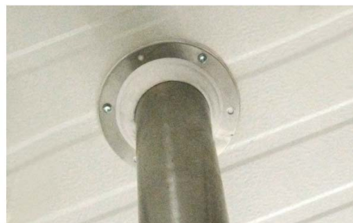
灵活的柔性穿墙管套形成密封，以防止污染物的转移。
