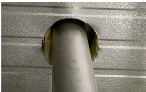
开孔和部分密封的孔会产生和转移污染物。
